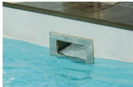
Régulateur de niveau d'eau mécanique, pour largeur 140 mm, corps laiton ou bronze, couvercle rectangulaire inox pour skimmers 160
